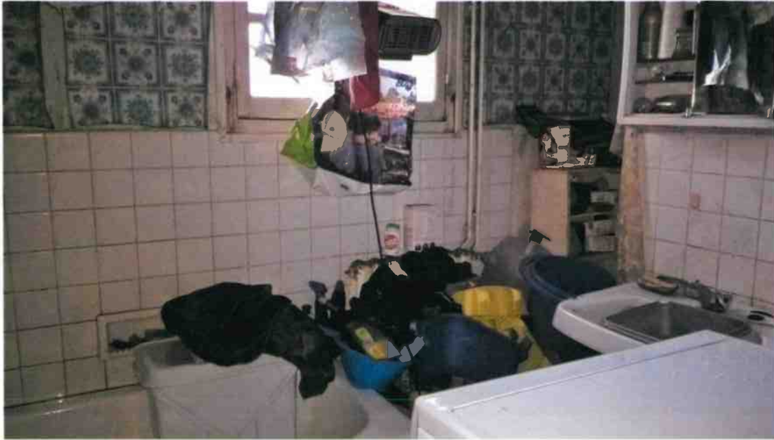
Les sanitaires se trouvent en rez-de-chaussée.
